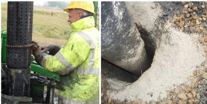
Rys. 44 Zabudowa studni gazowej – instalacja filtra (z lewej), żwirowanie i uszczelnienie otworu (z prawej)
