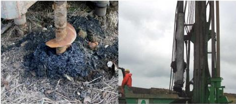
Rys. 42 Wiercenie studni pionowych – z lewej: świdrem spiralnym (szenkiem); z prawej świdrem rurowym (szapą)
