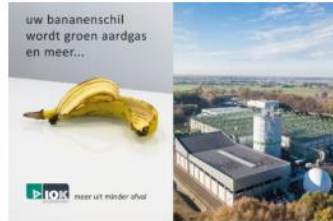
Energiecentrale groen gas
