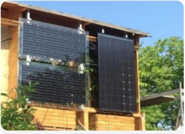
Figura 2.5 - Un esempio di possibile installazione di pannelli fotovoltaici su pareti verdi
