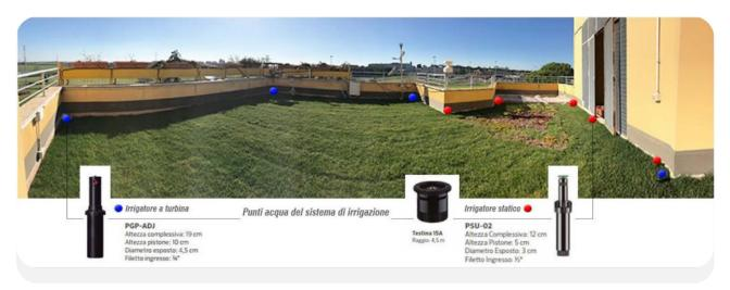
Figura 5.19 - Dettagli del sistema di irrigazione sul tetto verde ENEA, C.R. Casaccia, Roma
