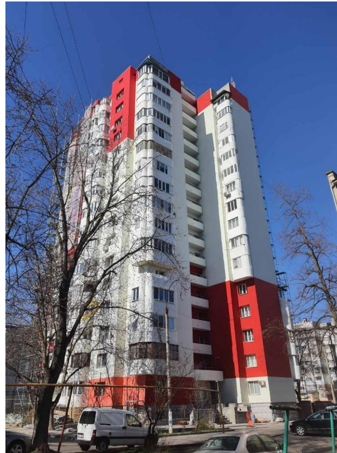
Blocul reabilitat termic
