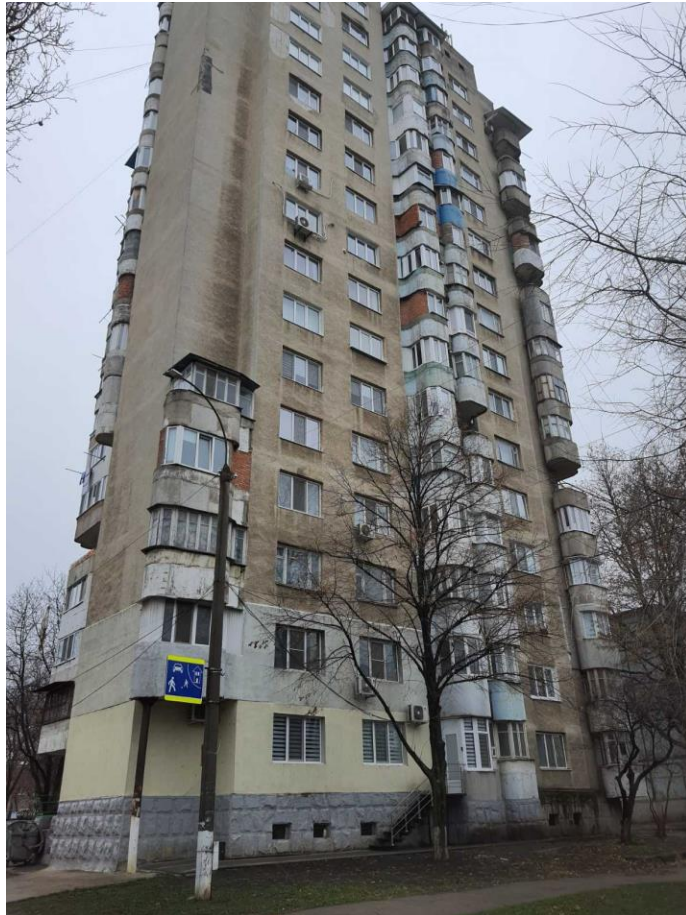
Blocul până la demararea lucrărilor
