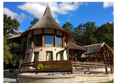
Pictured above: Dám Pont Látogatóközpont in Hungary
