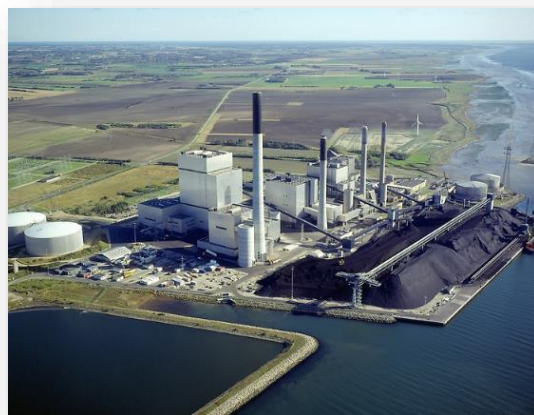
Photo: Aalborg Energikoncern. Nordjyllandsværket Power Plant.
