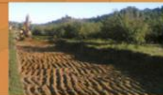
Decapatge de terra vegetal.
