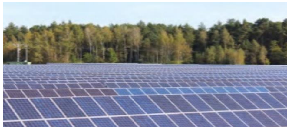
Photovoltaics farm in Bordziłówka (Lubelskie)
